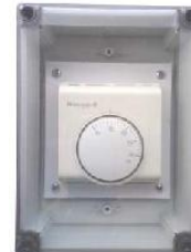
Thermostat d'air extérieur (facultatif – fourni par l'installateur)
