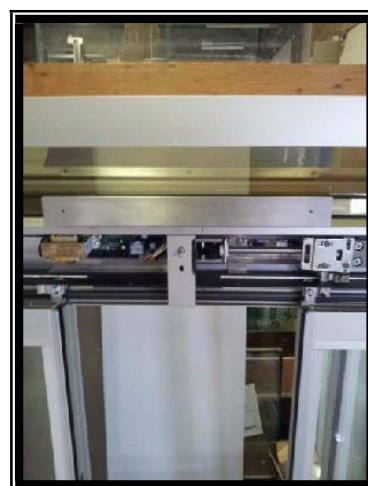
2 – 3 Positionnement de l'AMB au centre du linteau
