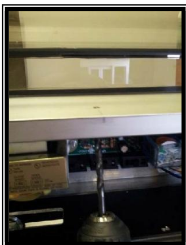
4 Percer les trous de montage sur l'AMB
