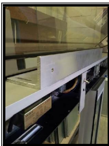
2 – 3 Positionnement de l'AMB au centre du linteau
