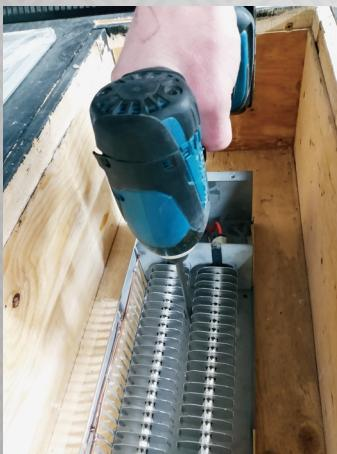
Utiliser les 2 trous de fixation dans le fond de l'appareil pour le fixer à l'aide de vis appropriées (non fournies).
