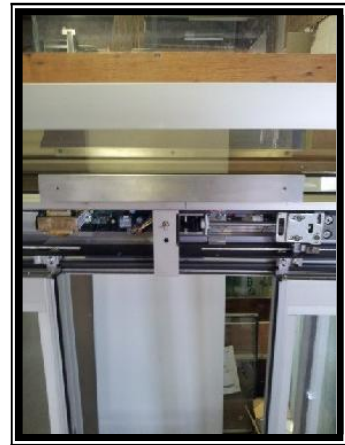
2 – 3 Positioning AMB at center of header
