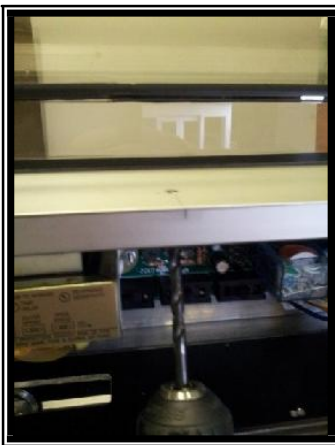
4 Drill AMB mounting holes
