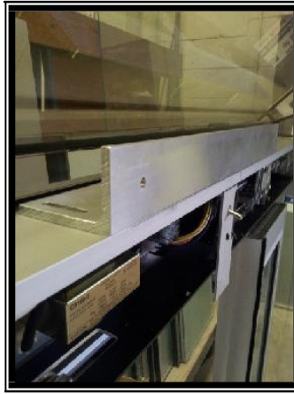
2 – 3 Positioning AMB at center of header
